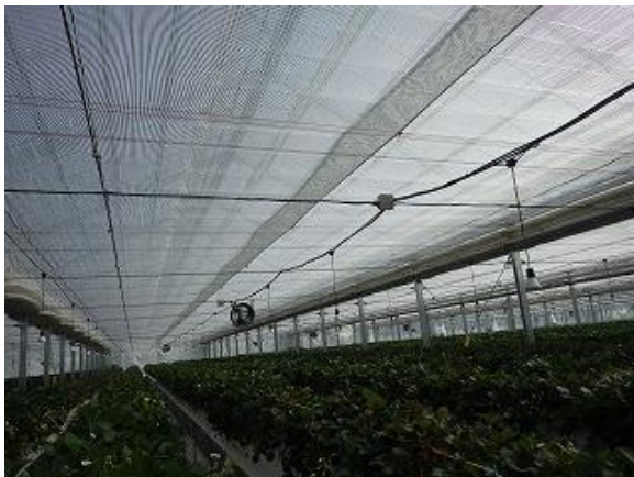
自動開閉の遮光カーテン (遮光率 52%)
