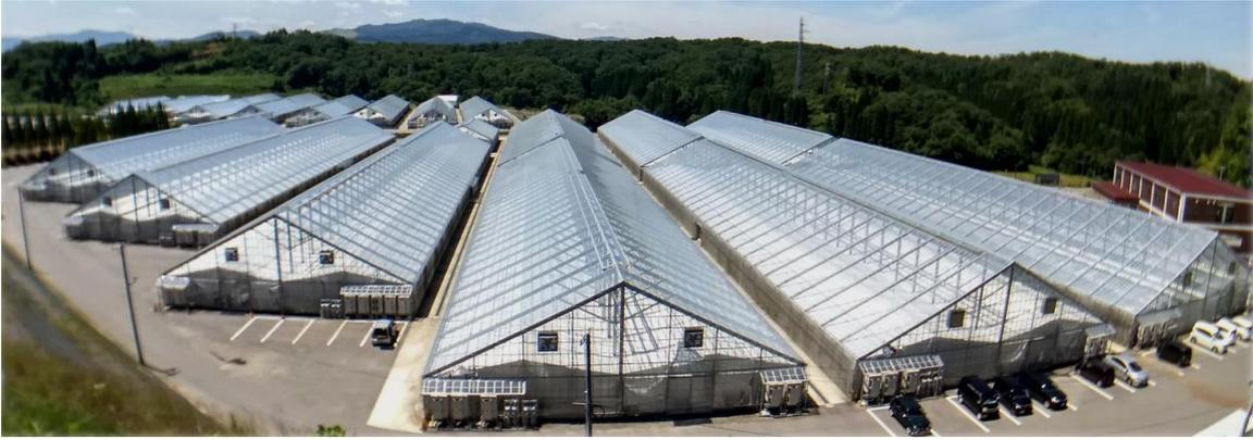
① ハウス全景（両屋根型鉄骨ハウス、南北棟、間口 20~24m）
