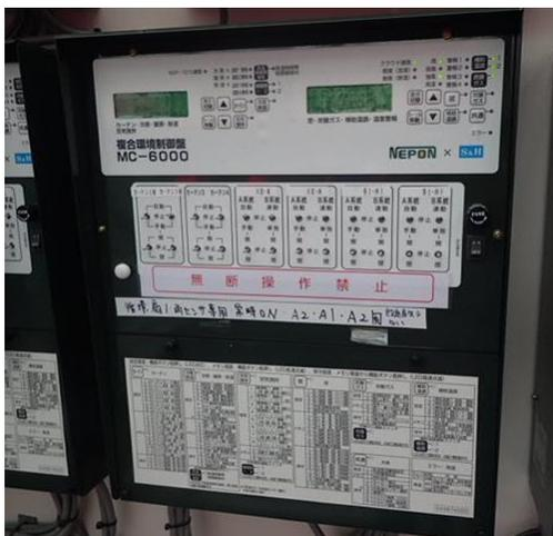
図 28 富山拠点の複合環境制御装置 (MC-6000 ((株) ネポン製))
