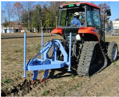
カットドレーンの施工状況
