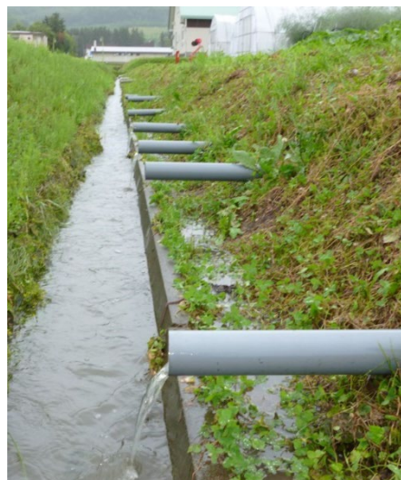
穿孔部へのパイプ挿入
