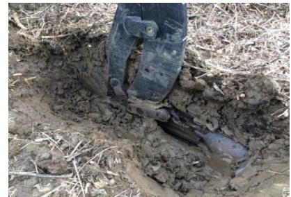
弾丸暗渠の穿孔状況
