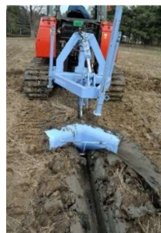
溝掘り時の状況
