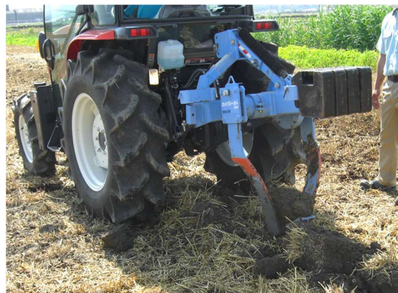
② 施工機を少し下げ、1 m程度後進
