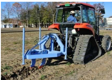
カットドレーンの施工状況
