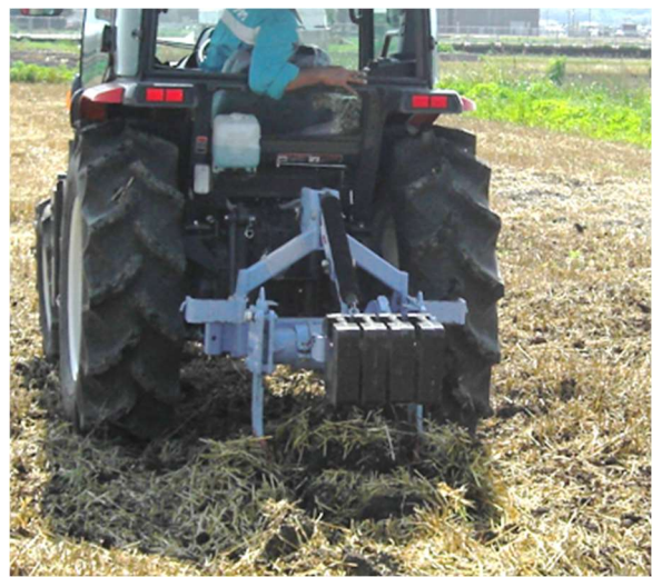
④ 詰まる前に施工した位置近くまで達したら、 施工機を所定の深さまで下げ、作業を続行
