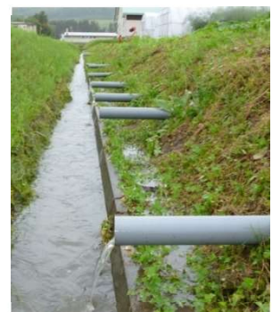
穿孔部へのパイプ挿入
