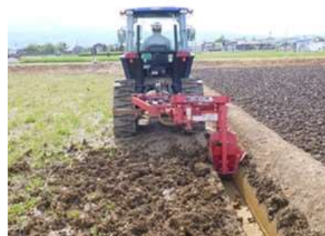
図 I - 2 排水溝の施工状況
