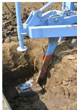
集水穴からの施工
