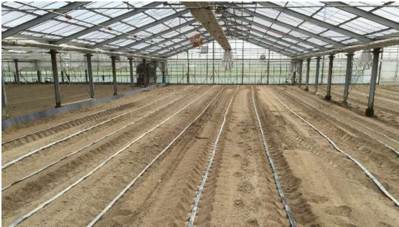
図 3-5 灌水チューブの設置
