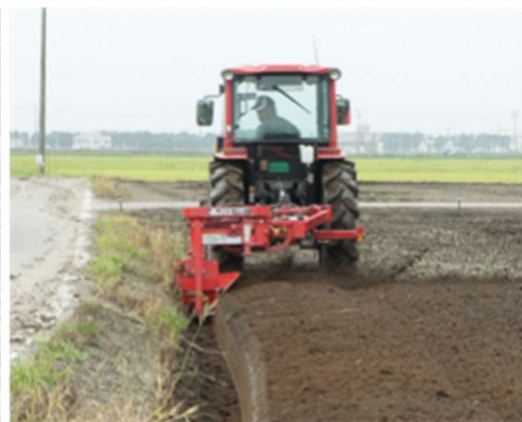
圃場周辺部への明渠の施工例
