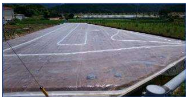
フィルム被覆、水枕設置
