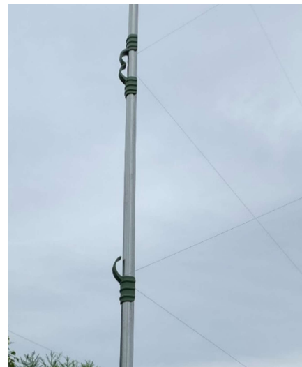
図VI-3 樹高に合わせて側面のテグス用の支柱を高くしたため内側にしなりやすく、テグスの抜けを防ぐ「返し」のフィルムトメールを逆向きに追加した
