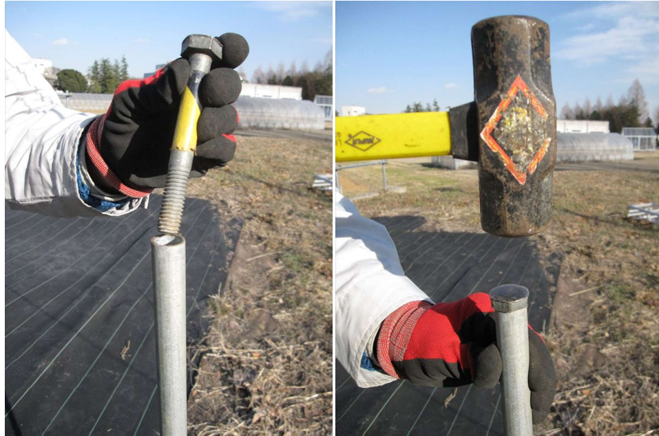
図Ⅲ-7 パイプ上端をつぶさないために、ボルトを載せて加減して打ち込む
