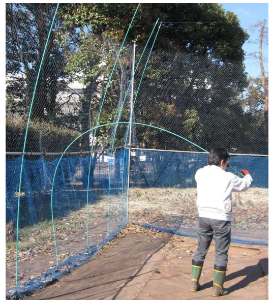
図Ⅲ-3 脚立を使わずに弾性ポールを曲げて作業できる
