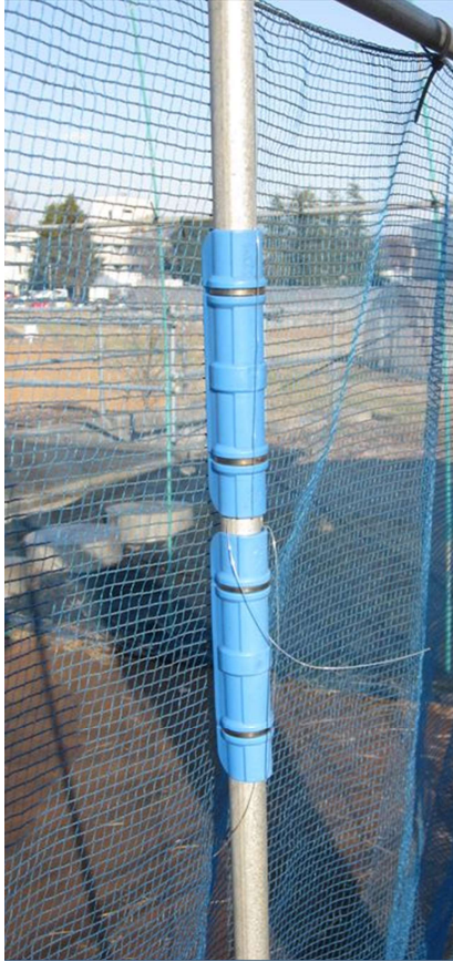
図Ⅲ-11 段ごとに、テグスの始端と終端それぞれをハウスパッカーで留める
