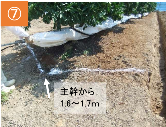
列の始端、終端も掘削。
