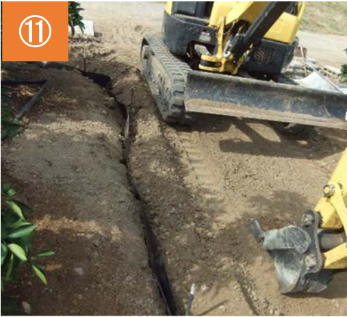
掘削土を溝に戻す。
