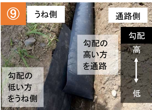
シートの継ぎ足しは 50cm 程度重ねる。通路勾配の高い方を外側（通路側）、低い方を内側（うね側）にする。接着剤等は必要ありません。
