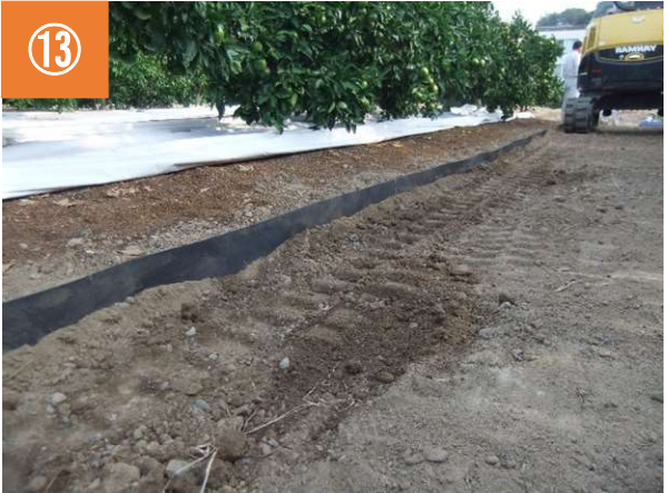
キャタピラーで通路側の埋め戻した部分を転圧する。 ※S.シートを踏まないように注意
