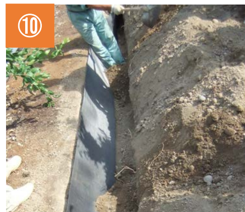
うね側に S.シートを当て、地表面から 5~10cm 出して土を一部戻す。
