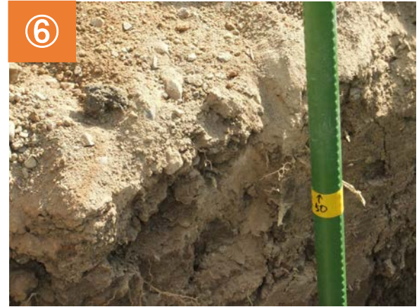
S.シートの埋設深である 50cm を確認しつつ進める。
