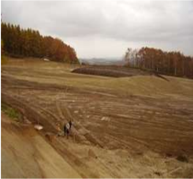
作土を避けて農地の基盤の傾斜を緩くする改良山成畑工による勾配修正
