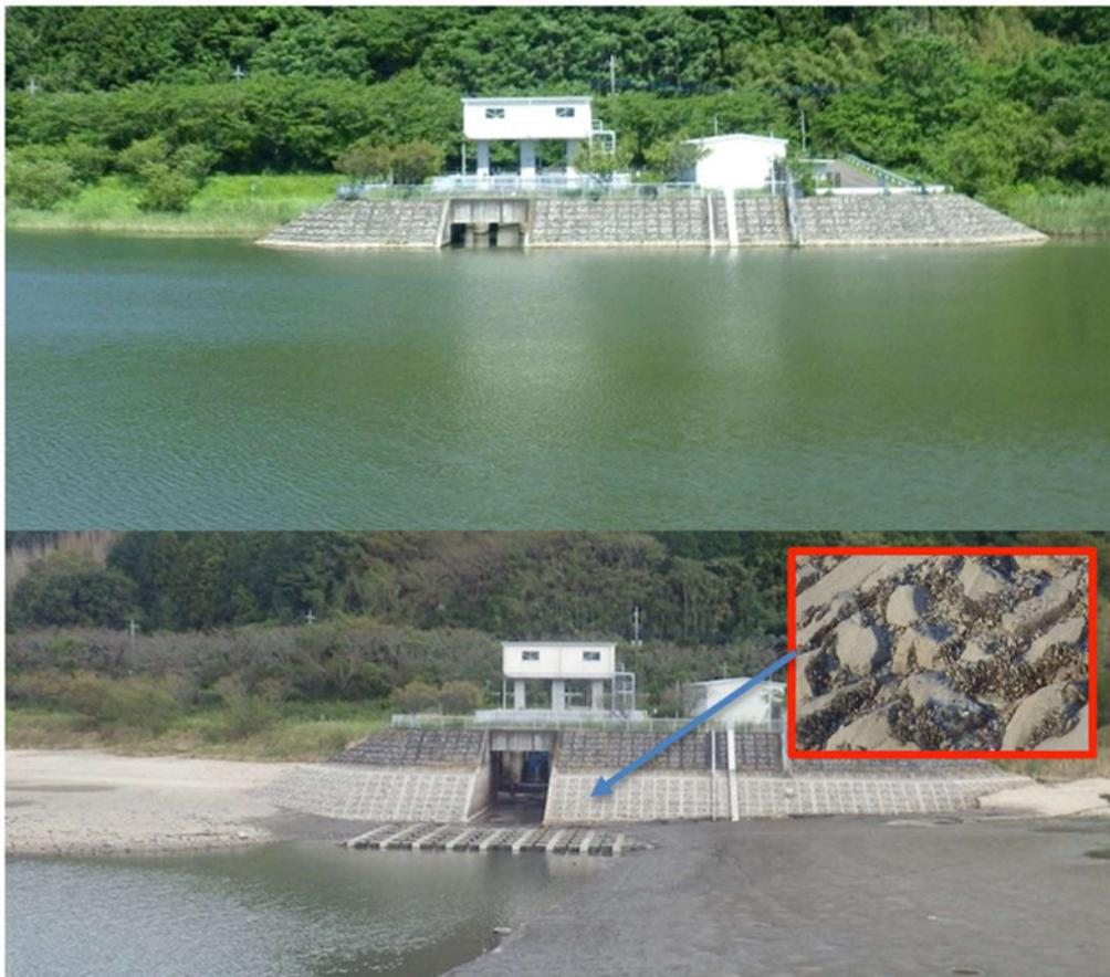
**図 I -2 カワヒバリガイ駆除を目的として落水した貯水池**
