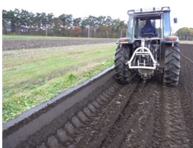
図 V-3 トラクタホイールでの踏圧による畦畔際の漏水防止作業の様子
