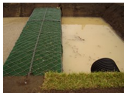
沈砂池の設置
