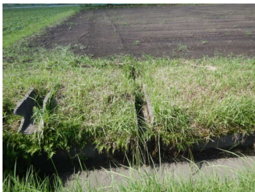
○ 明渠を排水路へ接続
