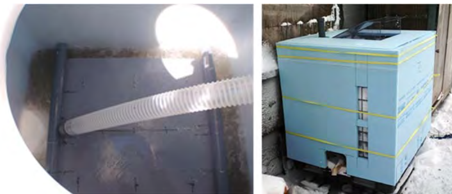
（左：ガイド板を設置した散気管、右：断熱加工）
