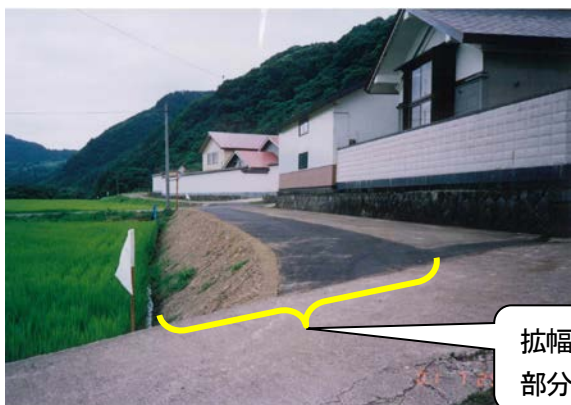
工事後の状況
