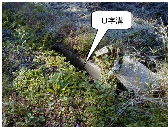
設置したU字溝
