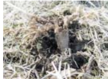
写真 - 5 凍上による被害
