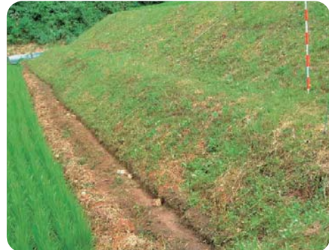
法尻位置への造成例 (鳥取県八頭郡智頭町大屋)
