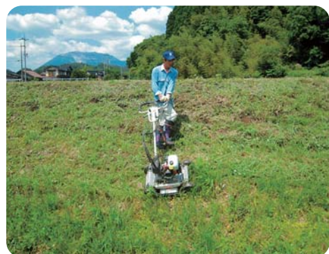
作業道からの草刈り作業
