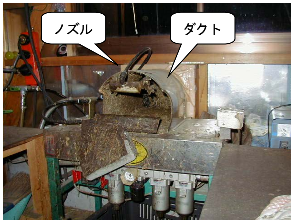
取り付けたダクト
