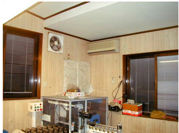
作目：ニラ 作業：選別・調製 目的：温度調節 方法：作業場内にエアコンを設置した。
