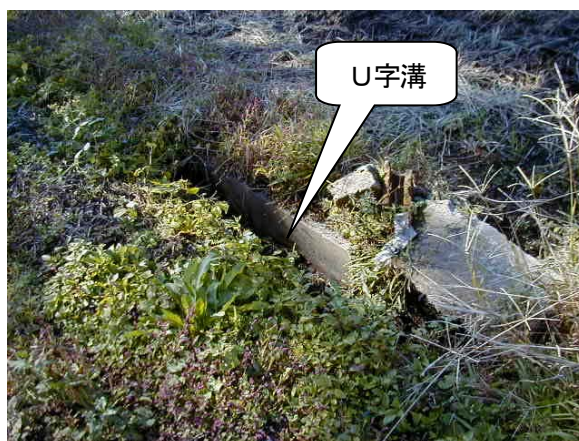
設置したU字溝
