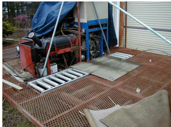
運搬車の台上の状態
