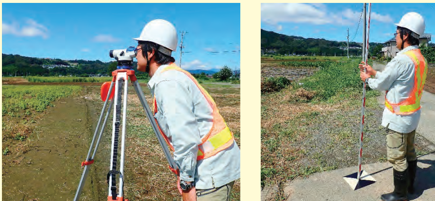
図 3-3 レベル測量の様子
