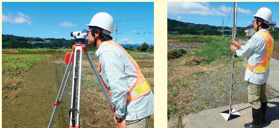
図 3-3 レベル測量の様子
