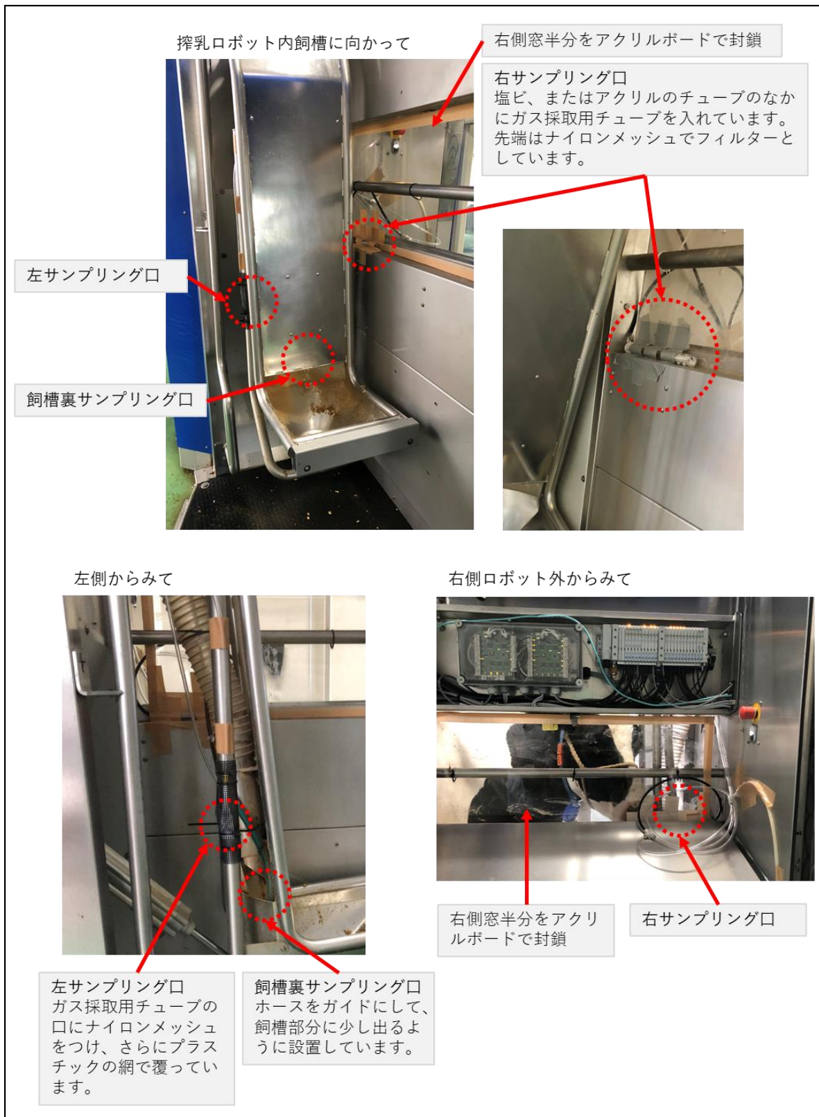
図 2-4 Delaval 社 VMS クラシック（家畜改良センター）での設置例
