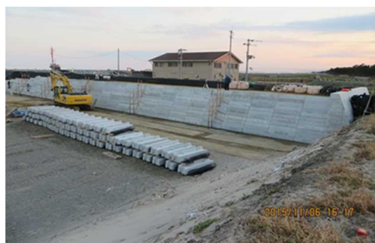
写真5.3-1 ジオテキブロック仮置きヤード
