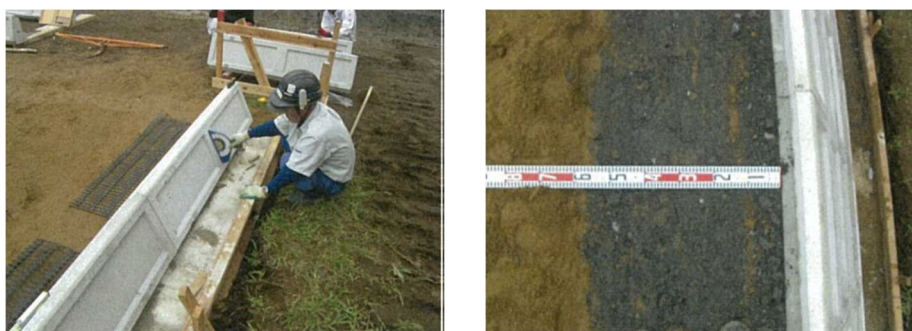
参考写真3.5-2 軽量ジオテキブロックの施工状況（1段目）
