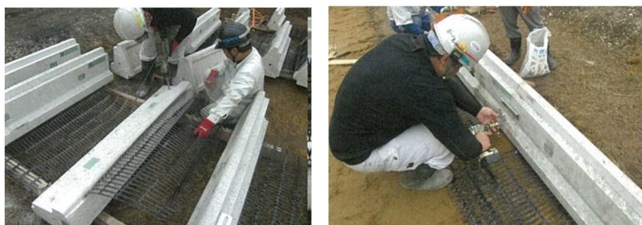
参考写真3.5-3 ホールインアンカーと連結板による隣接する軽量ジオテキブロックの固定状況
