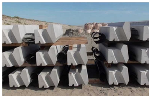
写真5.8-2 ジオテキブロックの仮置き状況
