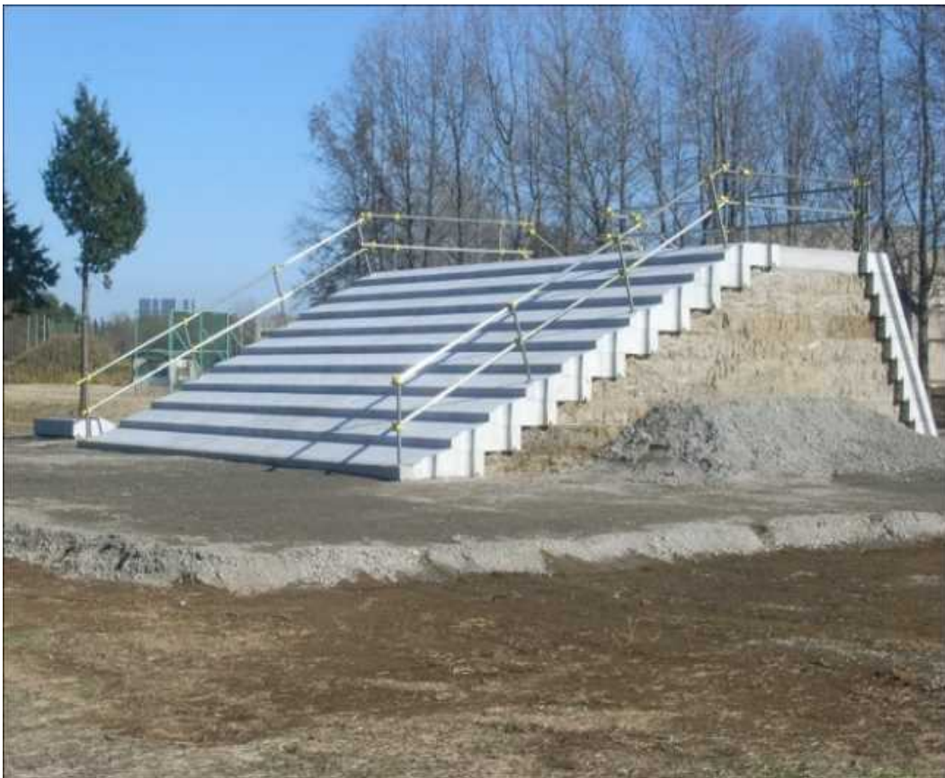
ジオテキブロック工法による堤防の試験施工事例
