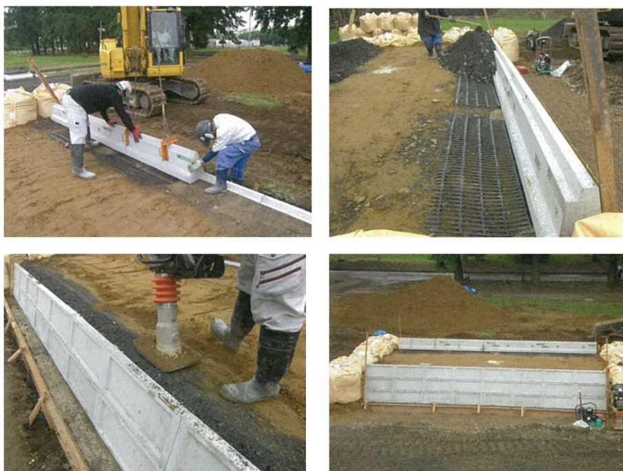
参考写真3.5-4 軽量ジオテキブロックの施工状況(2段目)
