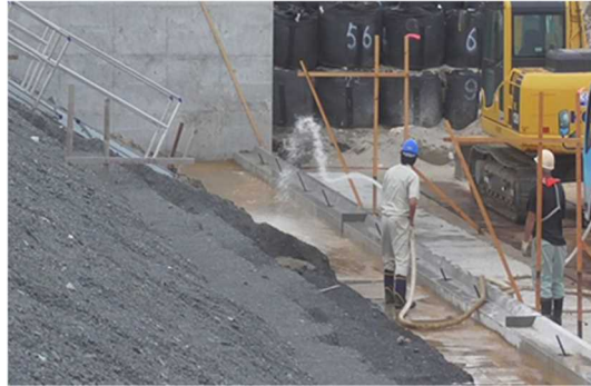
写真 5.9-2 散水養生の施工状況
