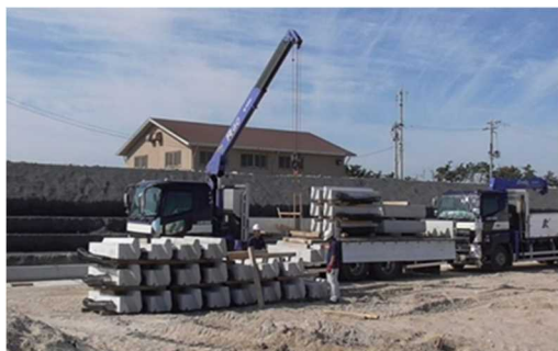
写真5.8-1 ジオテキブロックの搬入状況
