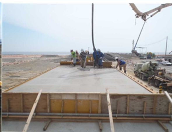
(b) コンクリート打設
