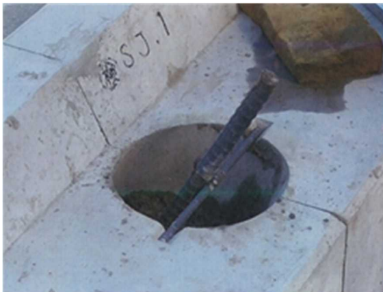
参考写真 2.3.4.3-1 連結鉄筋固定
