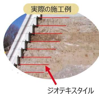
写真 2.2-3 ジオテキスタイルによって固定されたブロック積層構造
