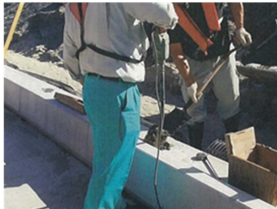
参考写真 2.3.4.3-2 コンクリート打設
