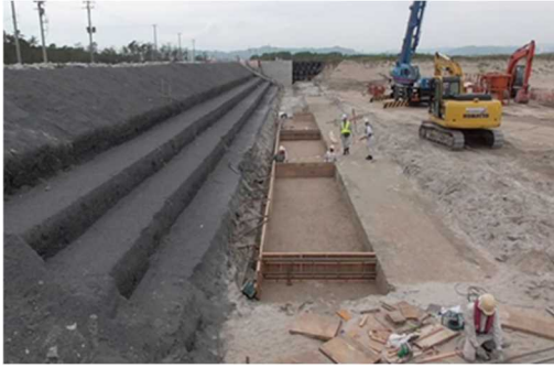
写真 5. 6-2 基礎コンクリート工の施工状況
