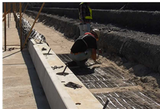
参考写真 2.3.4.1-1 ジオテキブロック設置
