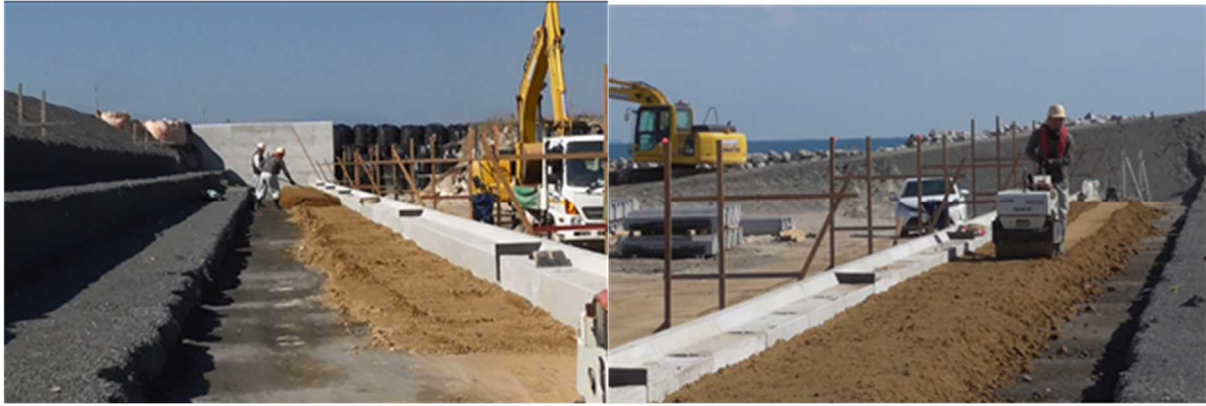
参考写真 2.3.4.1-3 セメント改良土の撒き出し 参考写真 2.3.4.1-4 セメント改良土の転圧
