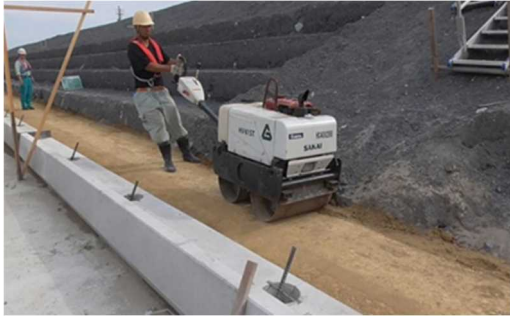
写真 5.9-1 セメント改良土工の転圧状況
