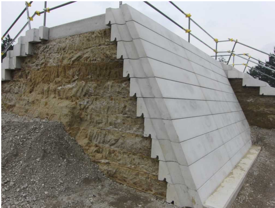
写真 2. 2-5 開口部を有しないジオテキブロックの積層構造
