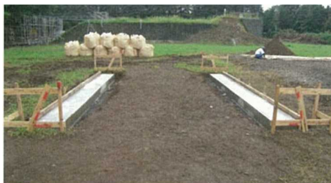
参考写真3.5-1 コンクリート基礎の外観
