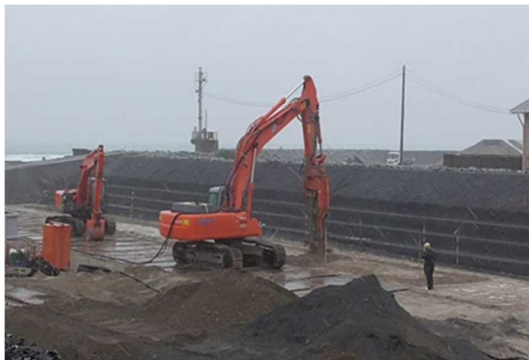
写真 5.6-1 地盤改良工（パワーブレンダー工法）の施工例
