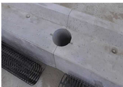
写真5.2-2 ジオテキブロックの連結孔
