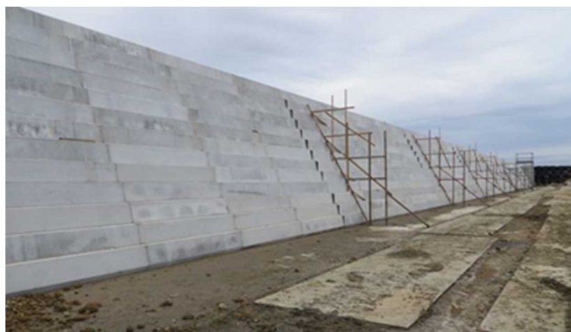
写真5.11-1 設置完了後のジオテキブロック
