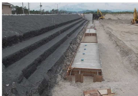
写真 5.7-1 段切りによる堤体盛土工の施工状況
