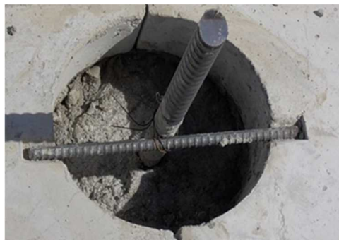
写真 5.8-5 鉄筋の固定方法の例
