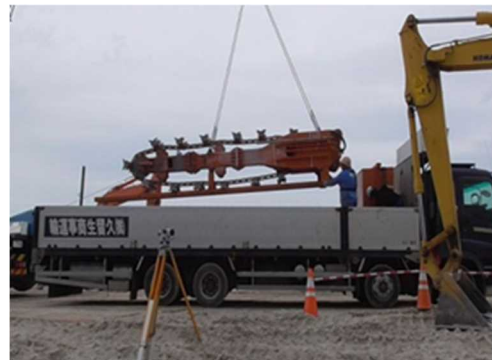
写真 5.6-1 地盤改良工（パワーブレンダー工法）の施工例
