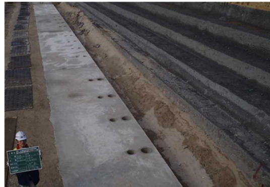
参考写真 2.3.3.2-2 基礎コンクート完了
