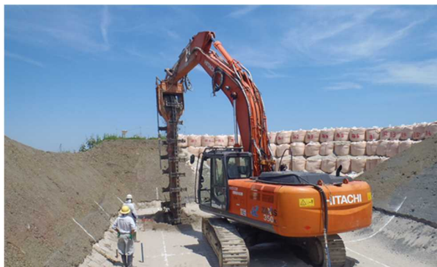
参考写真 2.3.3.1-1 地盤改良の様子
