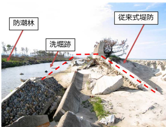
写真2.1-1 2011年の東日本大震災での被災事例 (1) 2)
