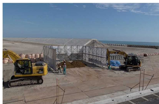
写真5.3-2 セメント改良土製造設備ヤード
