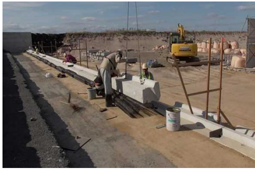
写真 5.8-3 ジオテキブロック設置状況
