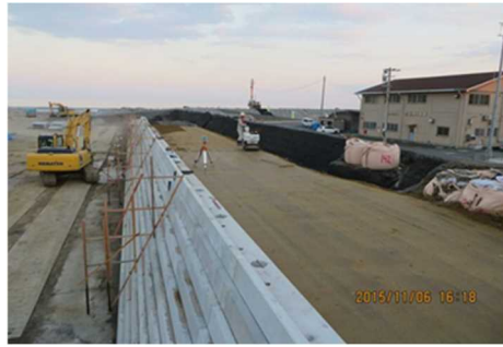
写真 5.9-1 セメント改良土工の転圧状況
