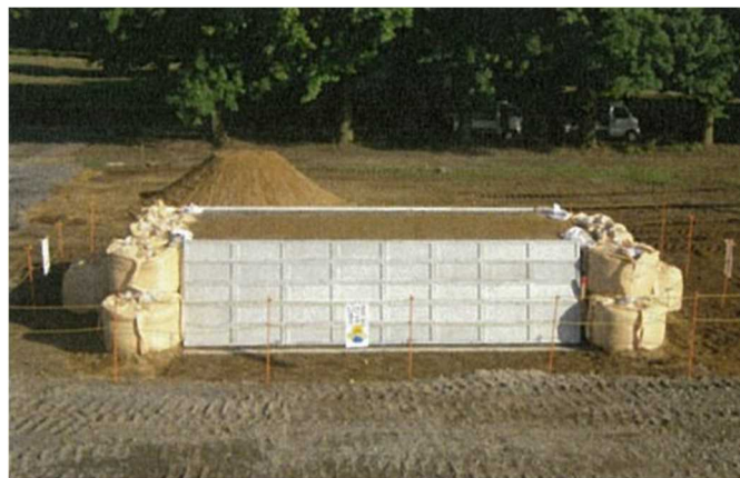
参考写真 3.5-5 軽量ジオテキブロック完成状況
