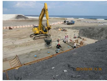
写真 5. 6-2 基礎コンクリート工の施工状況
