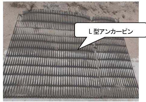
写真 5.8-4 L型アンカーピンによる固定状況
