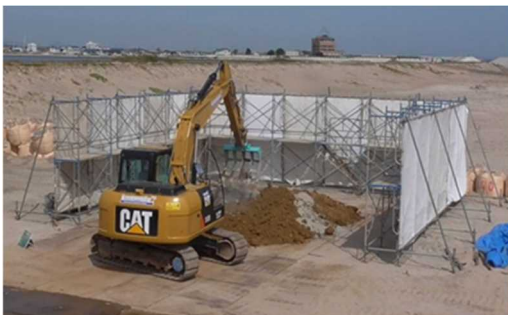
写真 5. 5-1 バックホウによるセメント改良
