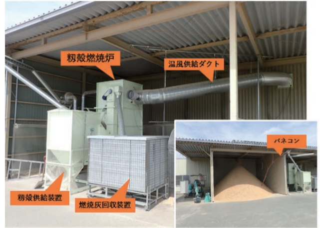
図2 2号機現地試験設置の様子
