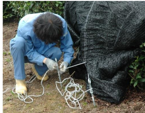
資材後端部の固定
