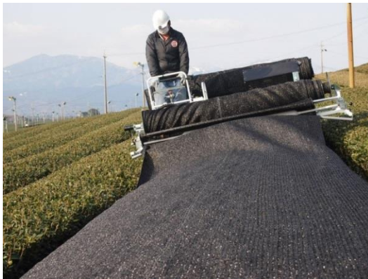
傾斜地での巻取り作業
