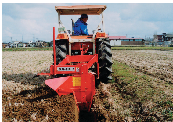
写真1 周囲明渠の施工
