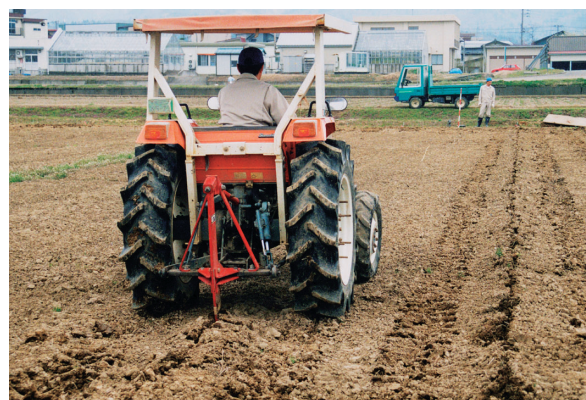
写真2 弾丸暗渠の施工
