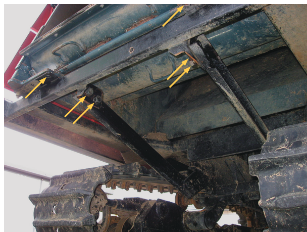
荷受けガイドの取り付けには既存のボルトを利用する
