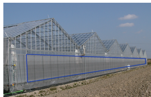
図 2 強制換気温室の吸気部における防虫網の取り付け事例
