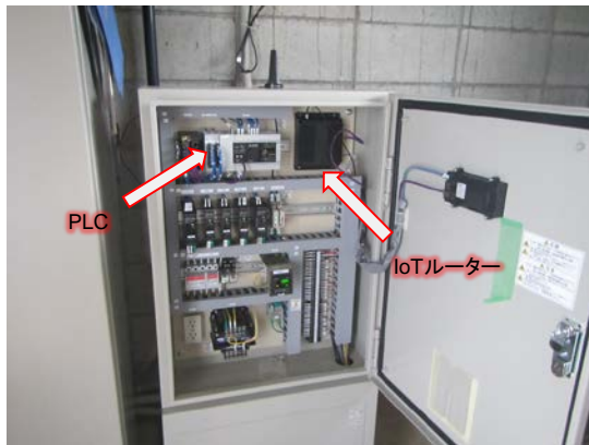
図 3.2-(4) 通信制御機器（左，PLC と IoT ルーター，右 LPWA 無線子機）
