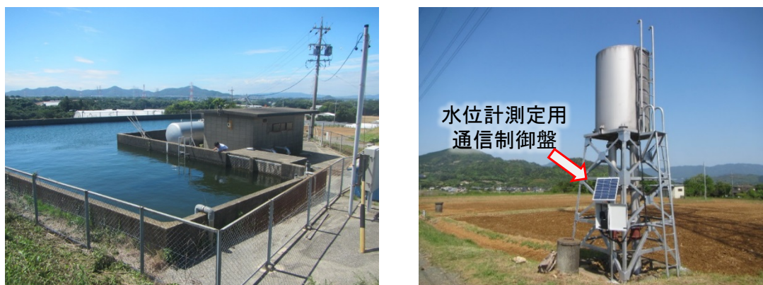
図 3.2-(2) 監視・制御対象 (左, ファームポンドとポンプ場, 右, 配水槽の水位監視)
