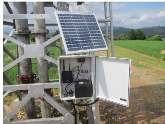
図 3.2-(4) 通信制御機器（左，PLC と IoT ルーター，右 LPWA 無線子機）
