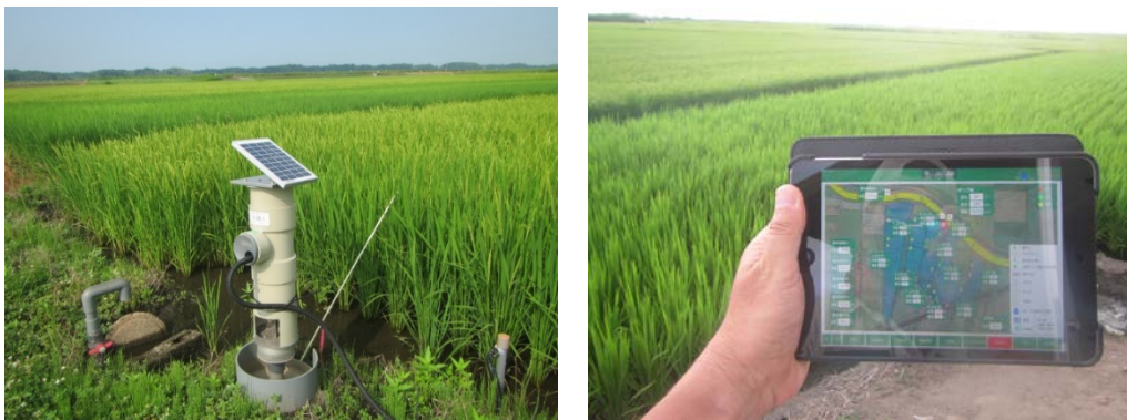
図 3.4-(2) 現地への自動給水栓設置状況 (左) とタブレット端末による監視状況(右)
