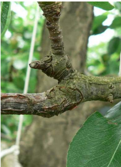
健全部との境に生じた亀裂
