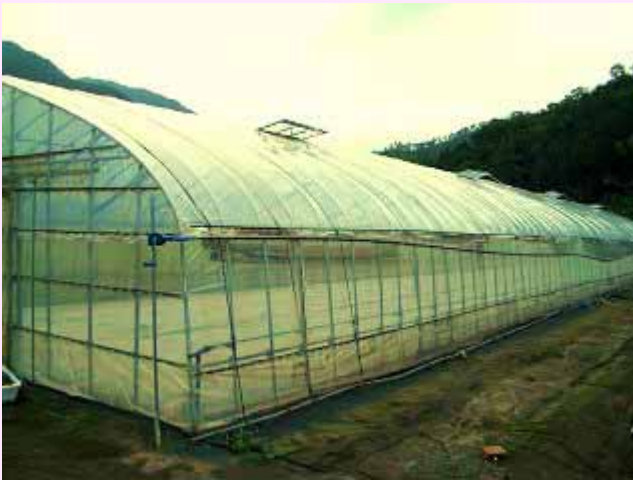
簡易天窗の設置
