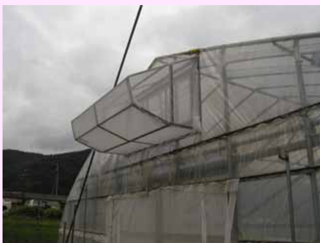
換気口の防虫ネット被覆
