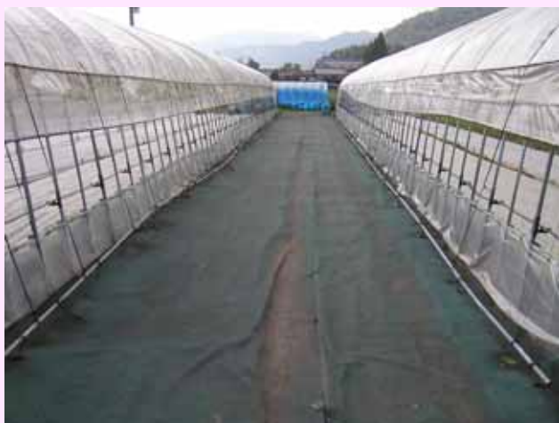
ハウス外側の防草用シート敷設
