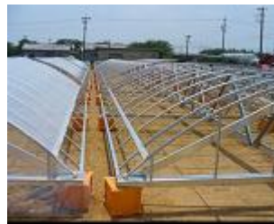
屋根ユニットの地上組立て
