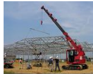
屋根ユニットのクレーン吊上げ
