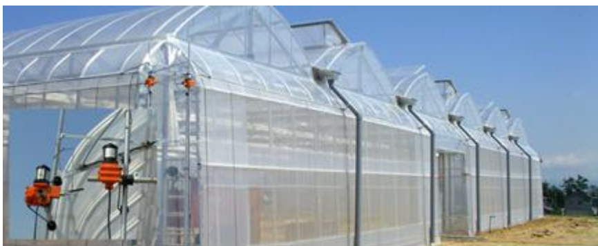
図 1-1-b3 サイド巻上げ換気装置（武豊モデル下段：自動制御式、上段：手動スイッチ式自動式）
