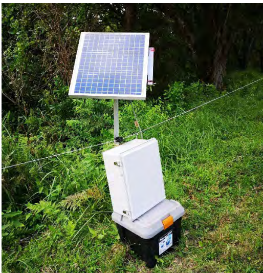
電気牧柵電圧監視システムと高張力線を活用した電気牧柵等により、省力的で安心な放牧地管理ができました。
