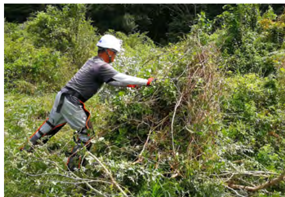
これまでの方法（刈払い機やチェーンソーで切断し、人の手で持ち出す）
