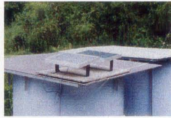
集水タンクの水を太陽熱電池を利用して園地最上部の給水タンクにポンプアップ
