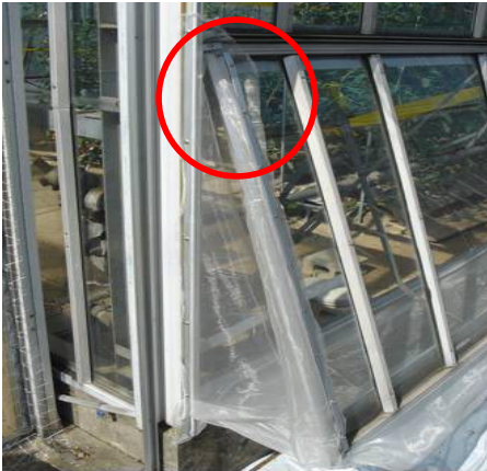
温室・跳ね上げ式側窓 シリコンを充填し、隙間なく
