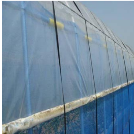
パイプハウス・単棟・側窓 ネットはパイプの外側に張り ます
