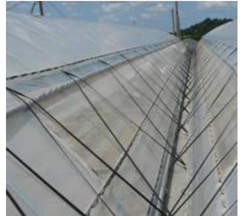
パイプハウス・連棟・谷 ビニペットで隙間なく
