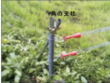
角の支柱の構造
