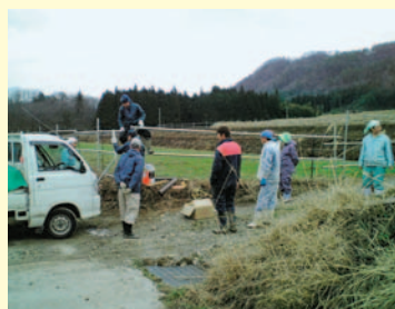
放牧馴致施設の建設
