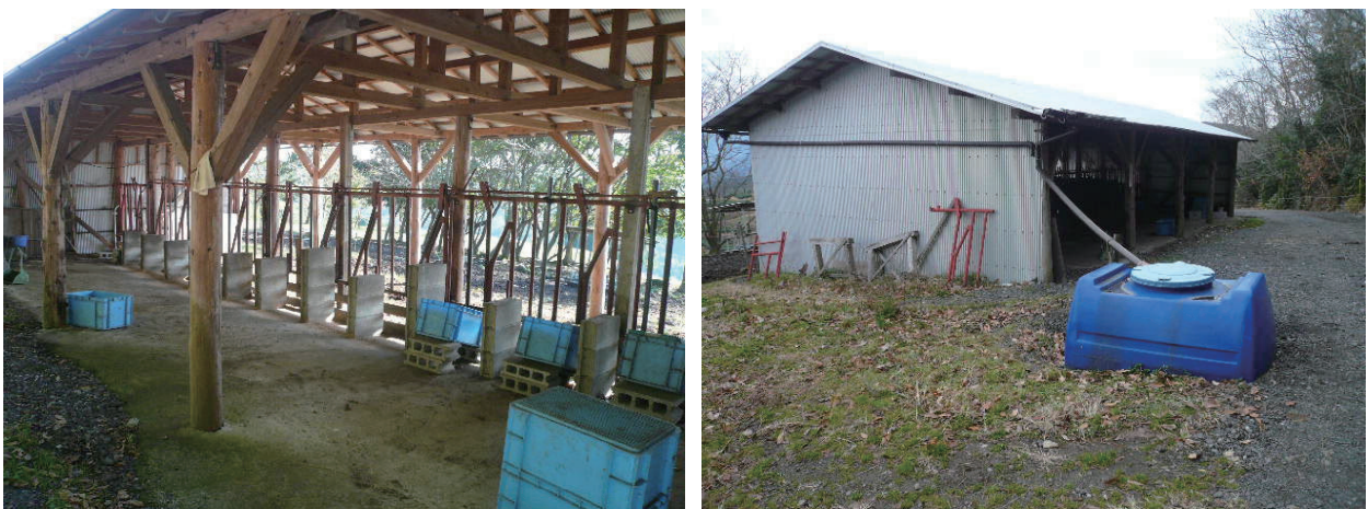
写真2 スタンションと集水用の屋根を備えた簡易牛舎
