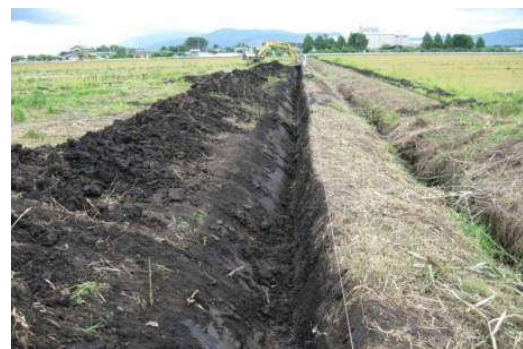
図8 遮水シートを用いた畦畔漏水対策事例(農工研)
