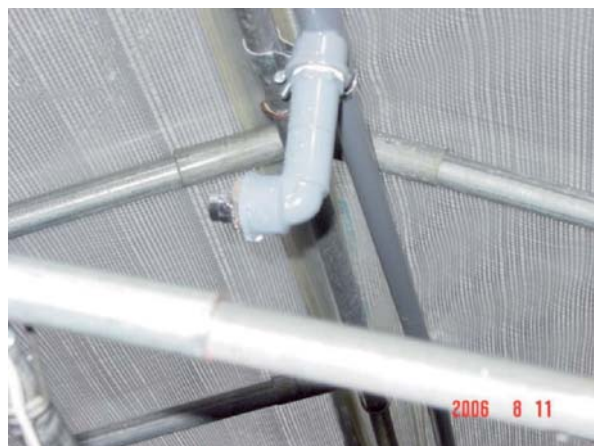
写真10 自然換気型細霧冷房のノズル
