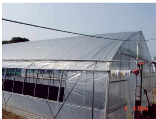
写真9 遮光資材を展張した自然換気型細霧冷房ハウス（巻き上げ式）
