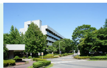
農業環境変動研究センター研究本館
