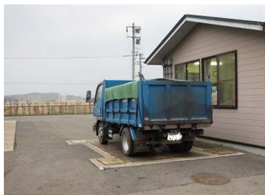
写真8 堆肥センターに設置されているトラックスケール
