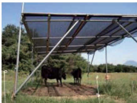
単管パイプと寒冷紗を利用した庇陰舎 (提供:近畿中国四国農業研究センター)
