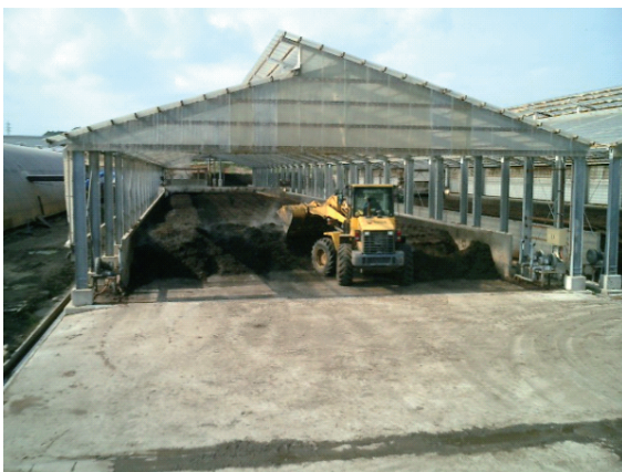
写真 7 S 牧場の堆肥化施設(開放型攪拌方式)
