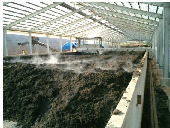
写真 8 堆肥化施設の内部
