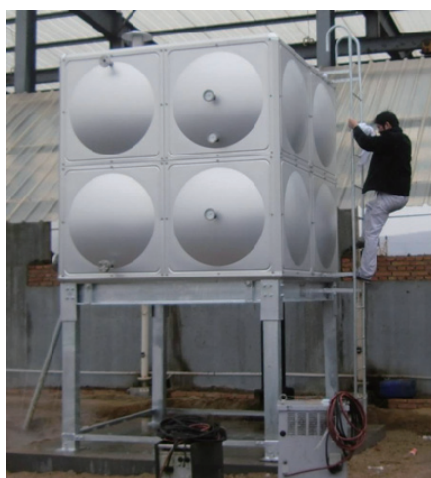
写真 7 B 牧場に設置された吸引通気方式用の熱交換器
