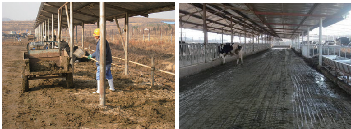
写真 6 シャベルと荷台によるボロ出し作業と(左)、ホイロードによるボロ出しのためにコンクリート土間打ち、屋根掛けされた給餌場周辺(右)
