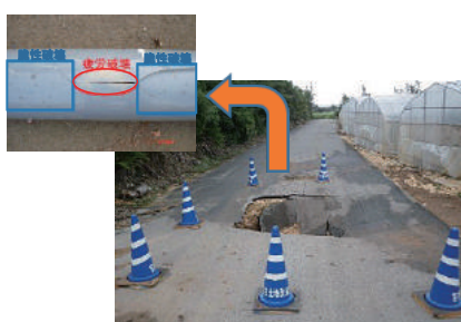
■パイプラインの圧力変動緩和装置
