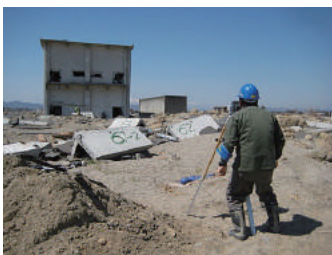
■ 津波被災状況の現地調査
