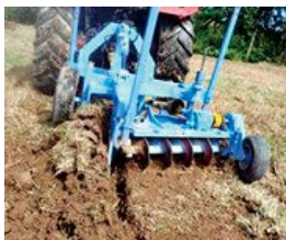
残渣を利用した補助暗渠カットソイラーの施工状況
