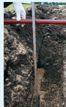
d. モミガラ疎水材の本暗渠施工後 深さ：管下70cm
