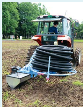
b. 施工状況(管理設時)
