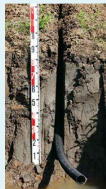
c. 暗渠管理設後 深さ：管下68cm
