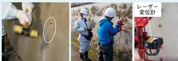
図1 摩耗量調査の現地作業
