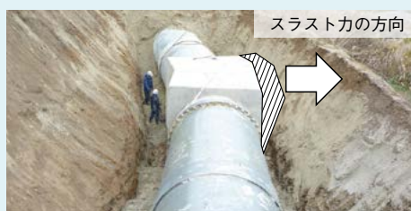
図4 グラウトの打設部
